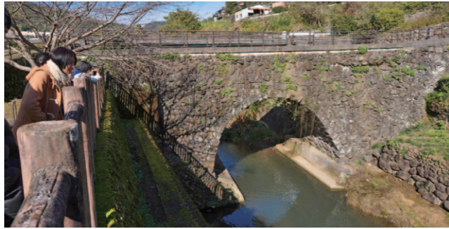
南島原市北有馬町にある元平橋。大正10年に架けられたこの石橋は、玄武岩を組んでつくられています。
