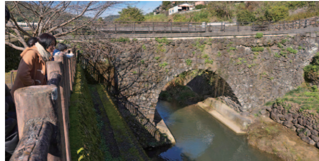
南島原市北有馬町にある元平橋。大正10年に架けられたこの石橋は、玄武岩を組んでつくられています。
