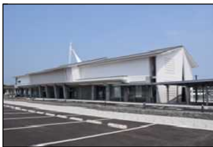
【代表施設】口之津港ターミナルビル
