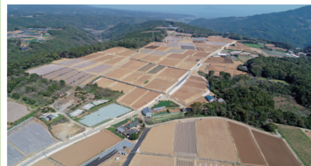
農業基盤整備事業(空池原地区)
