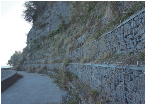
写真 4-⑦ 崩落防止対策工事
