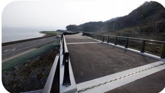
南有馬長浜跨道橋付近
