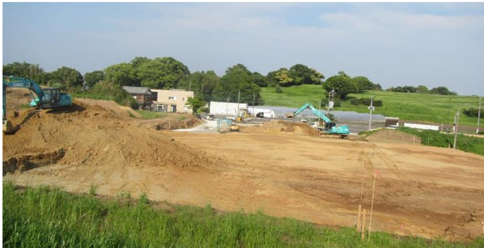
原城跡世界遺産センター整備工事（造成）の実施状況
