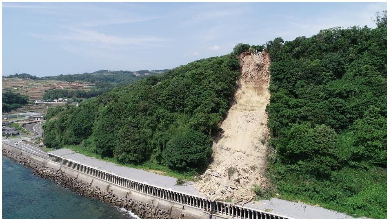
一般国道251号（赤間～権田間 R02.6.25 被災状況）
