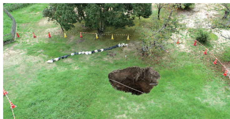
原城跡本丸 陥没
