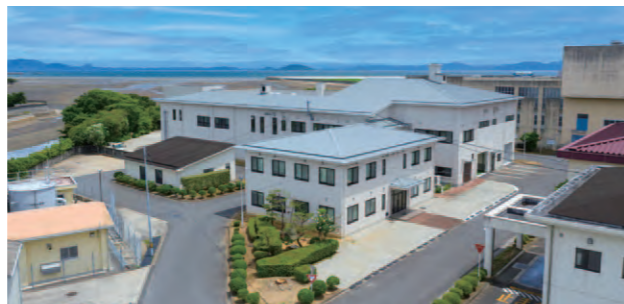
し尿処理施設基幹的改良工事事業
