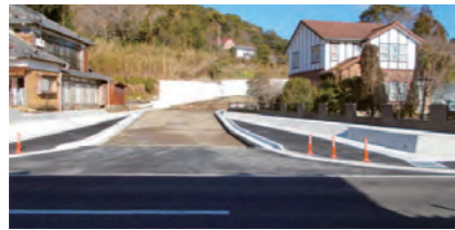
市道改良事業(東浜堀戸線)
