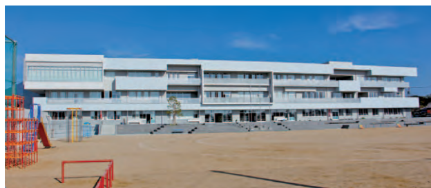
有家小学校校舎建設事業
