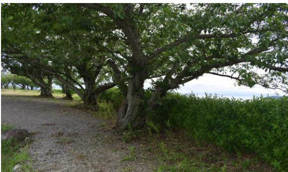
写真 5-11 本丸 石垣天端沿いの樹木
