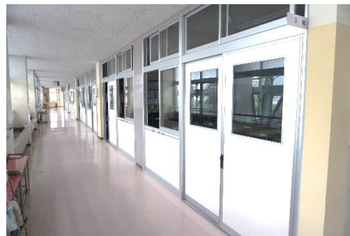
3階の窓扉・照明工事が終わり、 こちらも快適な環境です
