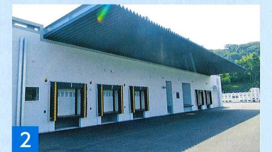
2 配送・回収口側
